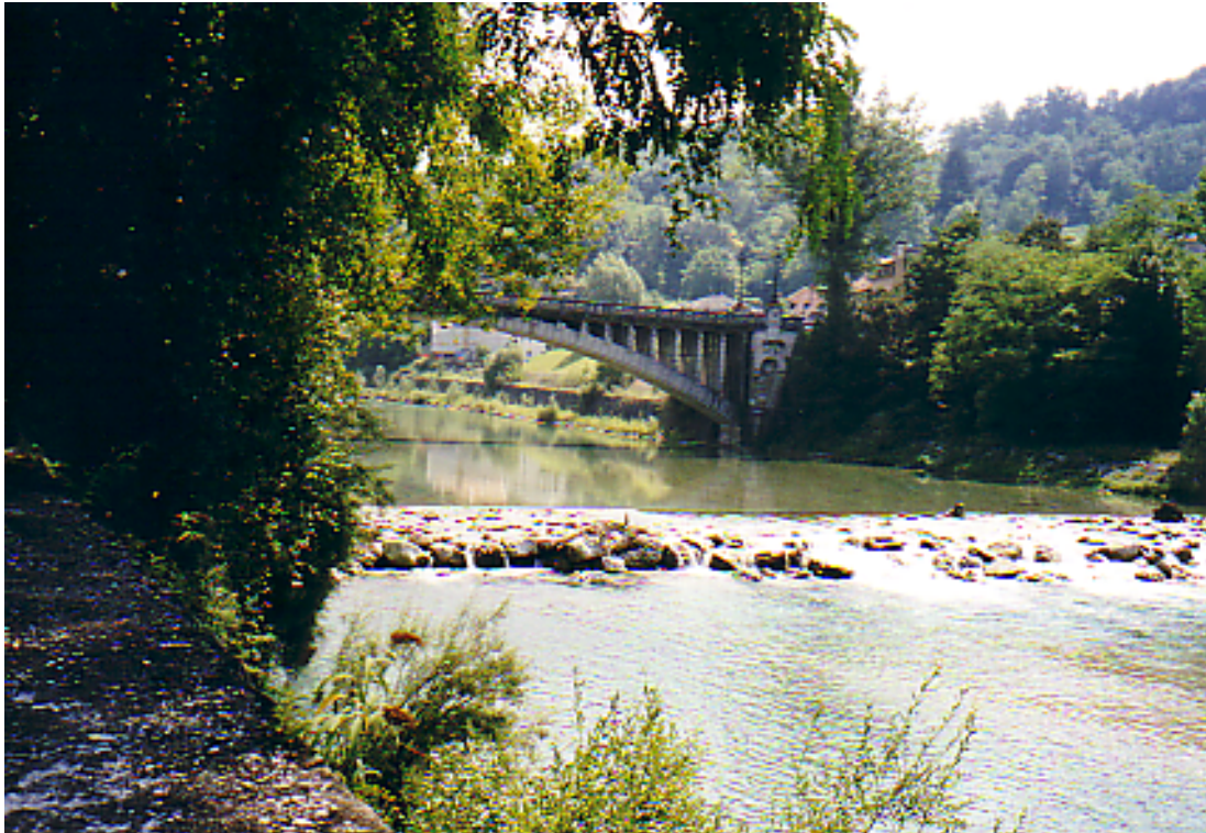
Brücke über den Piave bei Belluno
